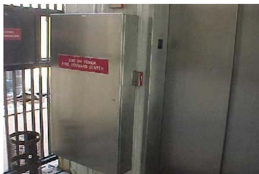
VpCI-386 透明漆噴佈於不鏽鋼電梯鐵門
