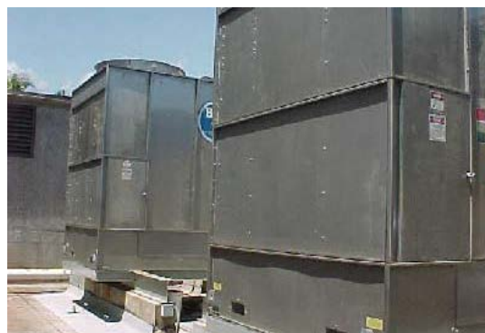
VpCI-386 透明漆噴佈於戶外電器設備的鍍鋅鋼板
