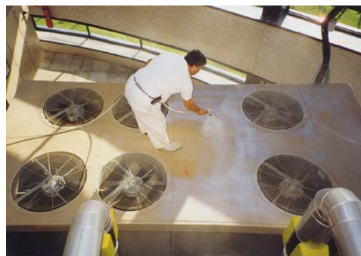
VpCI-386 透明漆噴佈於冷氣設備的彩色鋼板
