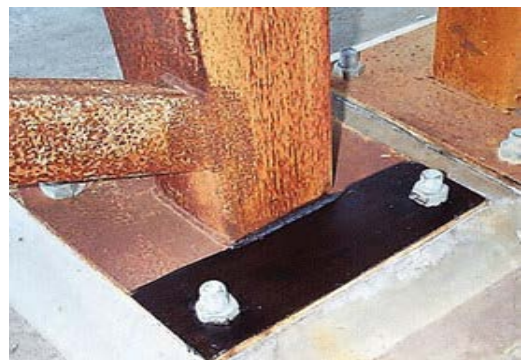
鏽層塗裝 VpCI 轉鏽漆轉鏽後呈黑色
