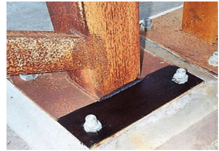
鏽層塗裝VpCI轉鏽漆轉鏽後呈黑色
