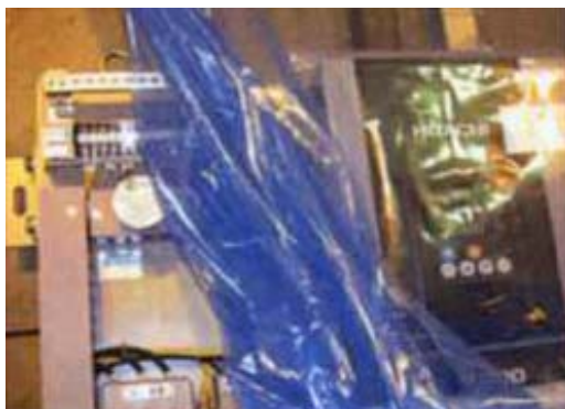
電子設備貼上 VpCI-111 散發器後以 VpCI-126 塑膠布覆蓋
