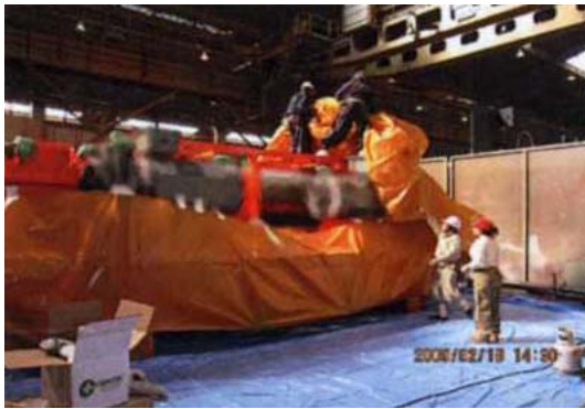
以 VpCI MilCorr 熱縮布將整個大型機械包覆
